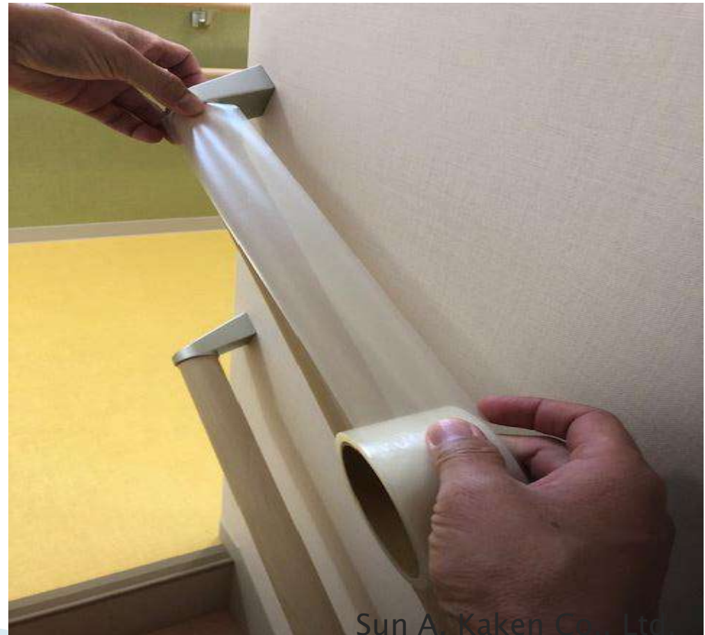
階段の手すり
